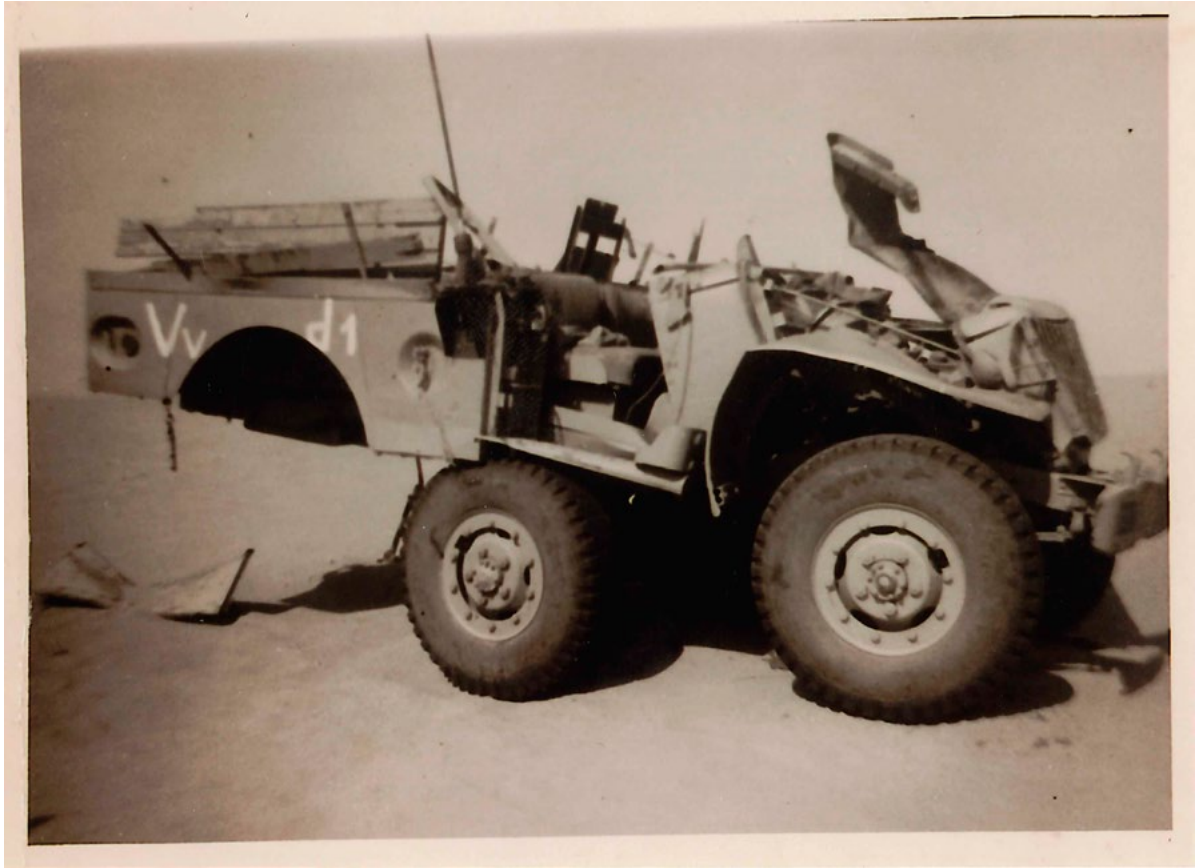
Image 2 : Effets d'un tir nucléaire sur les matériels positionnés sur une zone de tir
