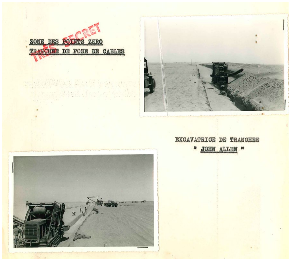
Image 4 : Pose de câbles souterrain sur le site nucléaire de Hamoudia, 1959
